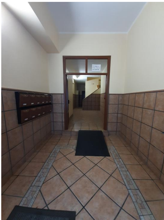
Interior del portal
