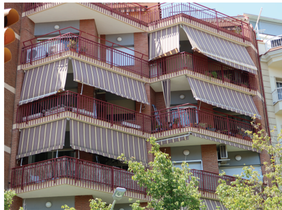
detalle de la planta 3ª, ventanas pisos 1ª y 2ª
