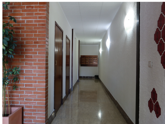
entrada comunitaria correctamente mantenida
