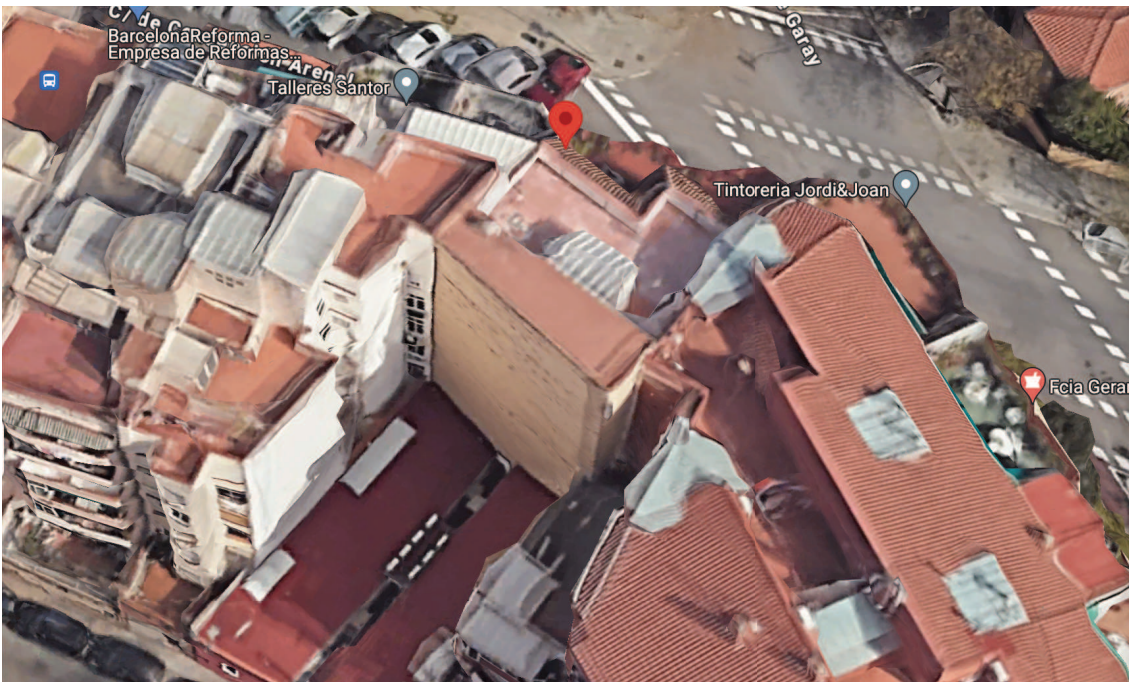
Google Maps - 3D - fachada trasera: sin ventanas por lo que las viviendas de cada planta están en la fachada delantera
